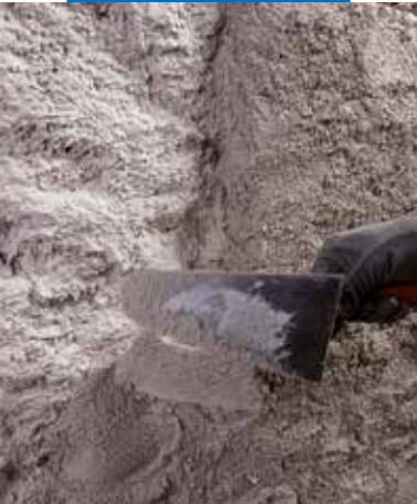
Applying Mape-Antique MC over Mape-Antique Rinzafo
